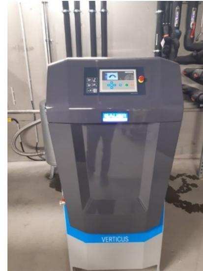
Récupération du gaz pompé et du gaz flash durant transfert : 60L évaporé en 1h30 soit 45m<sup>3</sup>)
